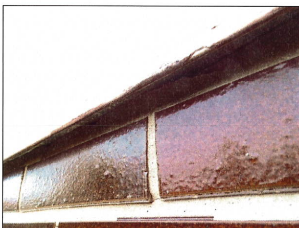
č. 27 Pavilon B, detail spojení střešního a obvodového pláště
