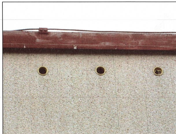
č. 21 Pavilon A, detaily atiky s VO, opatřenými plastovými mřížkami
